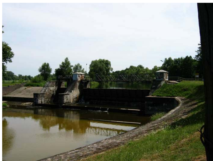
Włodzice Wielkie - śluza przy elektrowni wodnej
