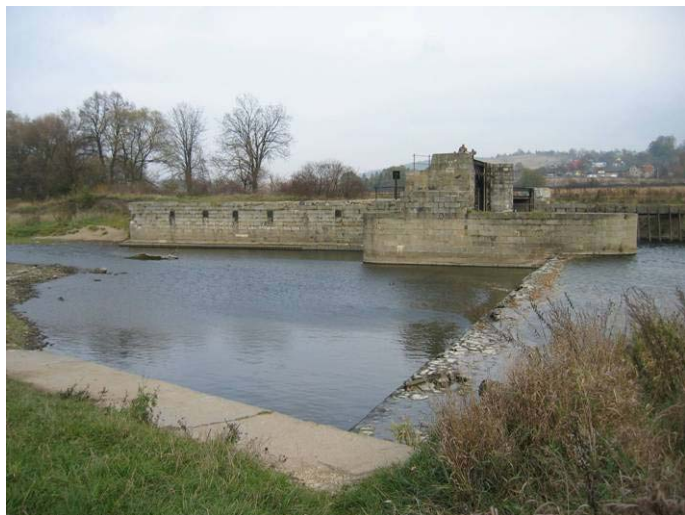
Jaz pod Kłodzkiem, obok oczyszczalni ścieków
