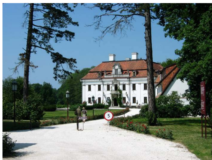
Krasków - Hotel Fundacji Rodziny Krasków
