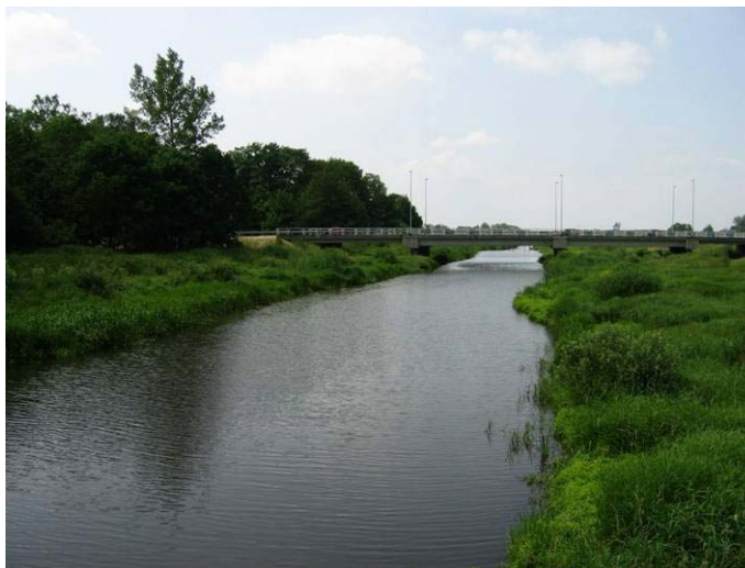
Żmigród - widok na most drogowy
