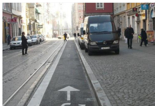
ZDJĘCIE 25. Polska, Wrocław. Asfaltowy kontrapas rowerowy na jezdni z kostki kamiennej.
