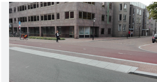
ZDJĘCIE 37. Holandia, Utrecht. Droga dla rowerów oraz chodnik przez wlot drogi podporządkowanej.
