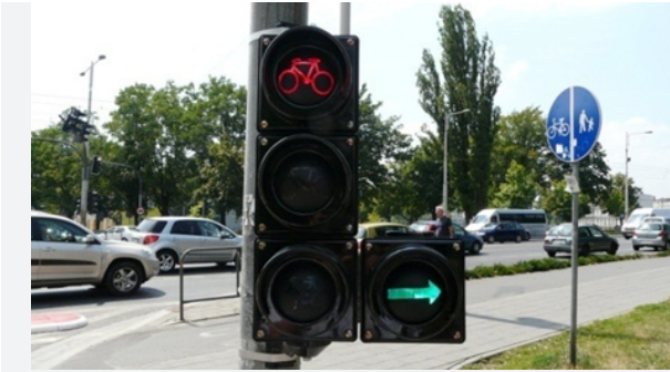
ZDJĘCIE 47. Polska, Wrocław. Sygnalizator S-1a z możliwością warunkowego skrętu w prawo.
