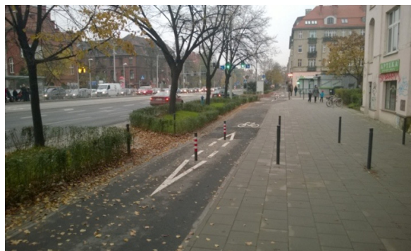
ZDJĘCIE 64. Polska, Wrocław. Słupki blokujące przed wjazdem samochodów.
