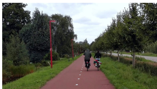
ZDJĘCIE 61. Holandia, Utrecht. Oświetlenie drogi dla rowerów.
