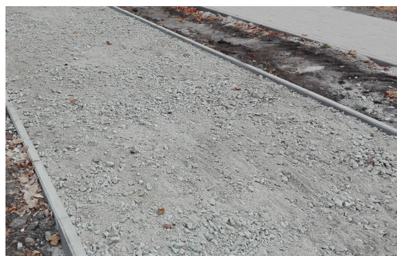
ZDJĘCIE 18. Wrocław. Podbudowa drogi dla rowerów.
