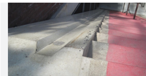
ZDJĘCIE 57. Holandia, Zwolle. Rampa do wprowadzania rowerów.
