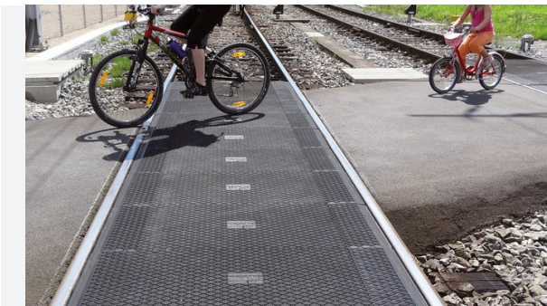
ZDJĘCIE 42. Bezrowkowy przejazd rowerowy przez linię kolejową:
