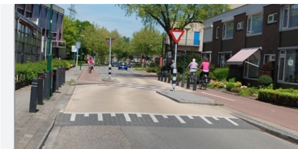
ZDJĘCIE 44. Holandia, Veenendaal. Połączenie dwukierunkowej drogi dla rowerów z pasami ruchu dla rowerów.
