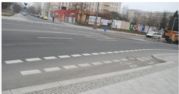
ZDJĘCIE 35. Niemcy, Berlin. Śluzą dla rowerów ułatwiająca wykonywanie manewru skrętu w lewo.
