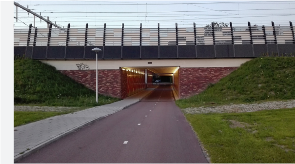
ZDJĘCIE 41. Holandia, Amsterdam, bezkolizyjne skrzyżowanie drogi dla rowerów z linią kolejową.
