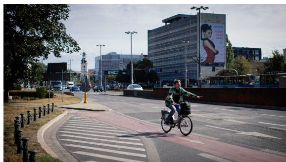
ZDJĘCIE 45. Polska, Wrocław. Zjazd z drogi dla rowerów na pas ruchu dla rowerów.
