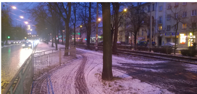
ZDJĘCIE 13. Polska, Wrocław. Brak poszerzenia i zbyt mały promień skrętu w ciągu drogi dla rowerów.
