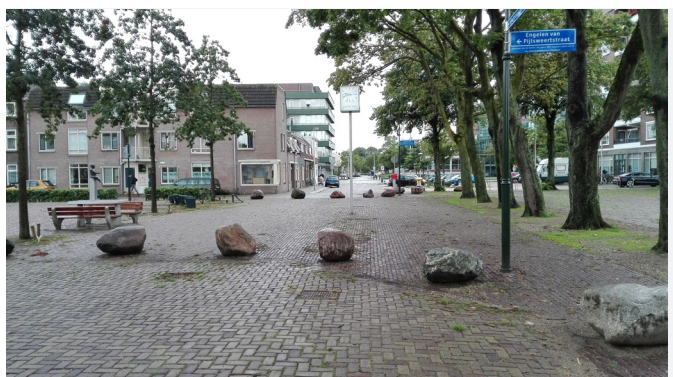
ZDJĘCIE 32. Holandia, Utrecht. Rozcięcie przelotowości ulicy.
