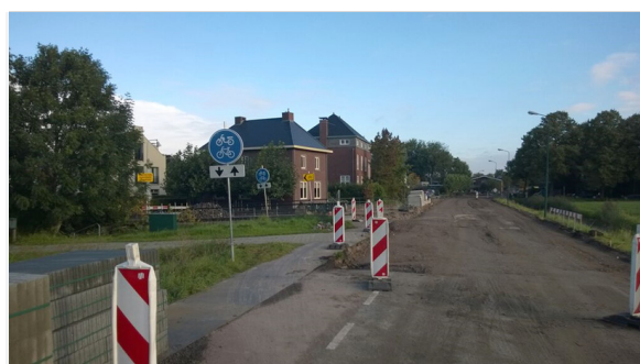
ZDJĘCIE 73. Tymczasowa nawierzchnia drogi dla rowerów z płyt stalowych.
