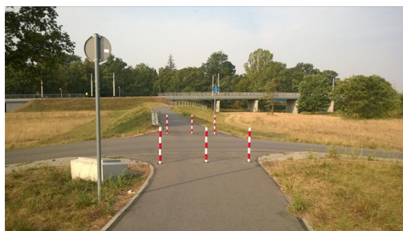
ZDJĘCIE 65. Polska, Wrocław. Słupki blokujące na koronie wału z uchylnym słupkiem w osi trasy.
