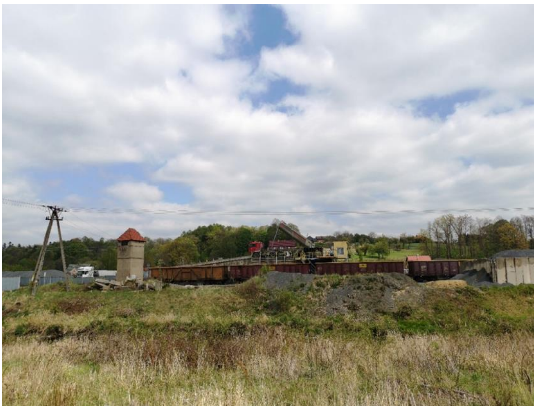
Fot. 8. Przeladunek kruszywa z samochodu ciężarowego na skład towarowy na punkcie ładunku kruszyw w Leśnej (fot. N. Derdacka, 2020)
