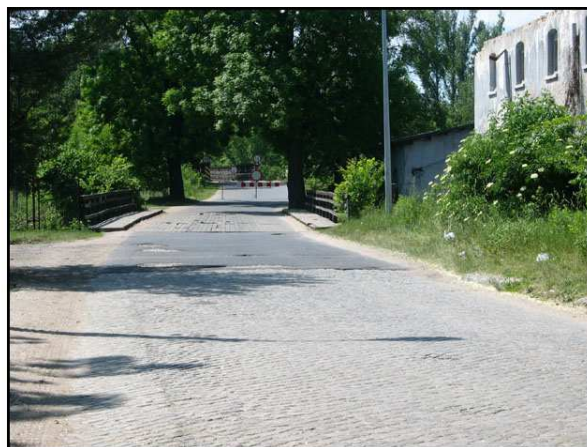
km 16,600 – most drogowy nad kanałem i rzeką w Świętoszowie, przy moście znajduje się proponowane miejsce wyjścia na brzeg i wodowania kajaka
