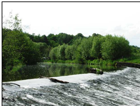
km 89,050 - jaz w miejscowości Szyszkowa
