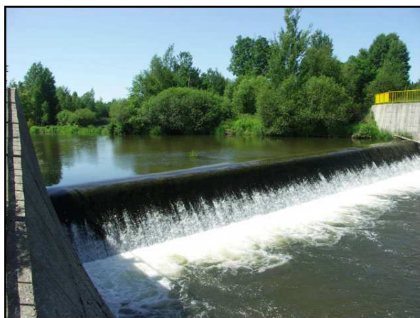
km 39,530 – widok na stopień piętrzący i miejsce przenoski na lewym brzegu przed stopniem
