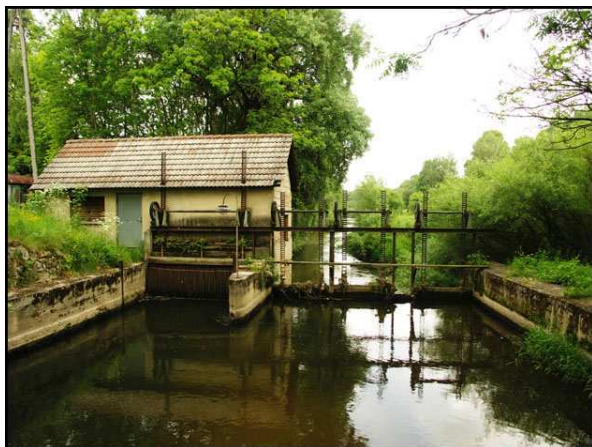
km 75,500 Widok na jaz i elektrownię w Radogoszczy
