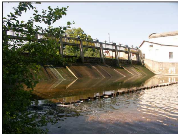
km 31,600 – widok z prawego brzegu za jazem na jaz i elektrownię w Przejęstawiu
