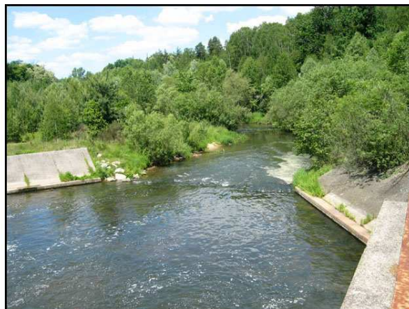
km 39,105 – widok na rzekę za stopniem piętrzącym i miejsce przenoski na lewym brzegu w Osiecznicy
