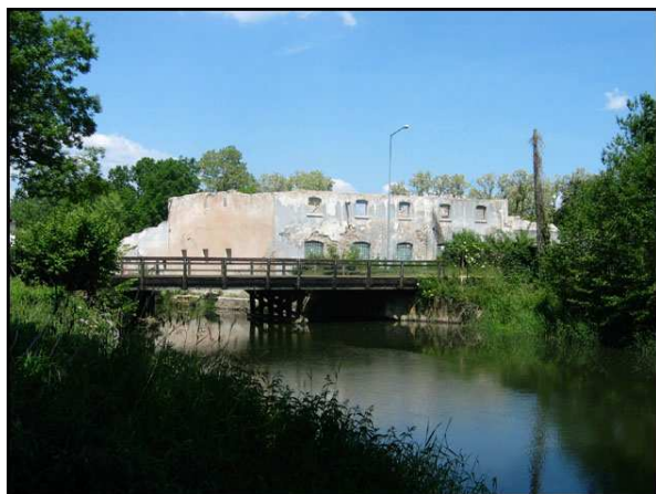
km 16,600 – most drogowy nad kanałem w Świętoszowie, na prawym brzegu kanału przed mostem proponowane miejsce wyjścia na brzeg
