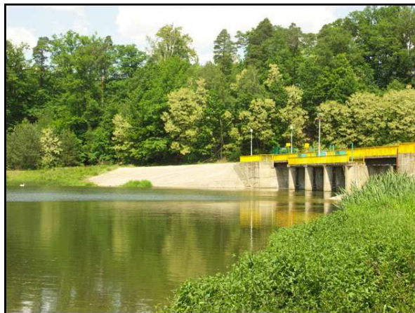
km 37,500 – jaz i elektrownia wodna w Kliczkowie, widok z prawego brzegu przed elektrownią
