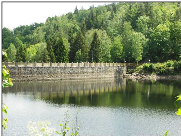
km 103,150 – Zapora Złotnicka
