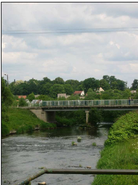
Widok z prawego brzegu Kwisy na most drogowy
