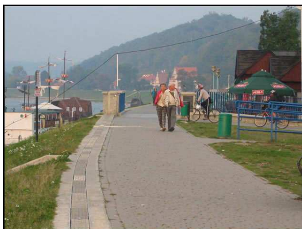
Kazimierz Dolny – ścieżka pieszo-rowerowa na wale przeciwpowodziowym i przystań statków wycieczkowych nad Wisłą
