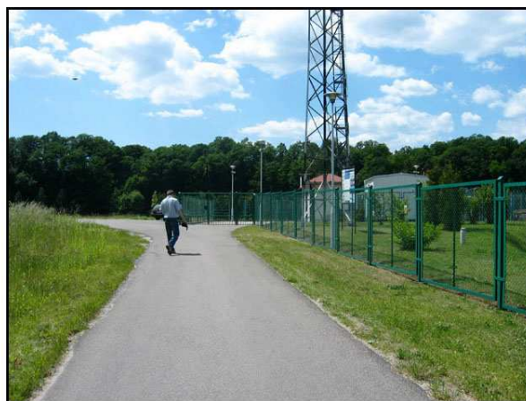
km 37,500 – asfaltowa droga dojazdowa i parking przy elektrowni w Kliczkowie, teren położony na prawym brzegu Kwisy, poza zasięgiem zalania wody 1%
