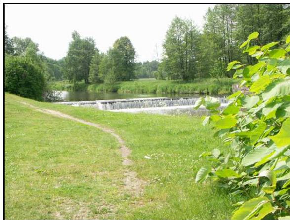
km 62,780 – jaz w Nowogrodźcu. Ścieżka piesza na prawym brzegu prowadzi do mostu drogowego nad Kwisą
