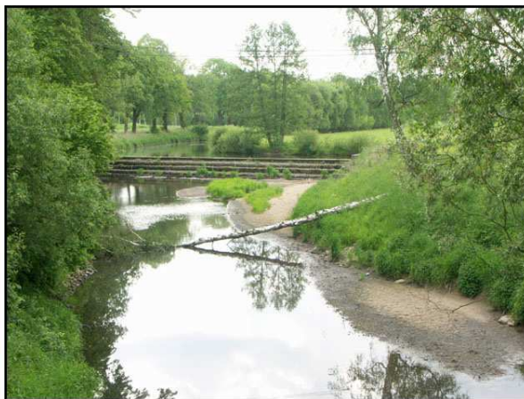
km 75,500 Widok na rzekę i kanał w Radogoszczy
