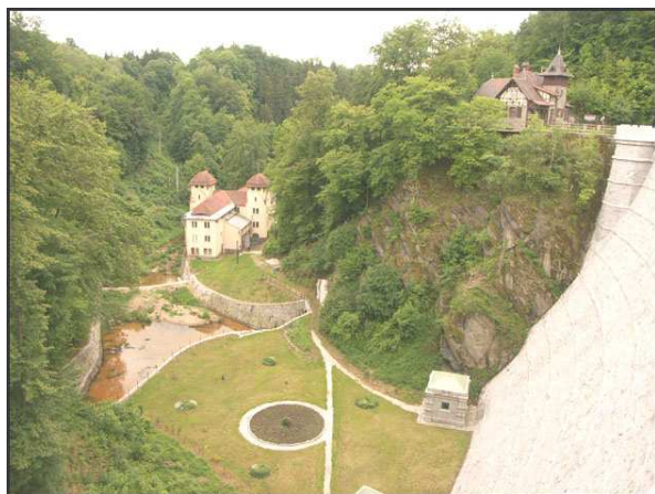
km 97,27 – widok z Zapory Leśniańskiej w dół rzeki, w dole budynek elektrowni
