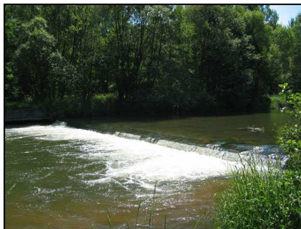
km 4,900 – widok na stopień regulacyjny w Rudawicy/Trzebowie i miejsce przenoski na prawym brzegu
