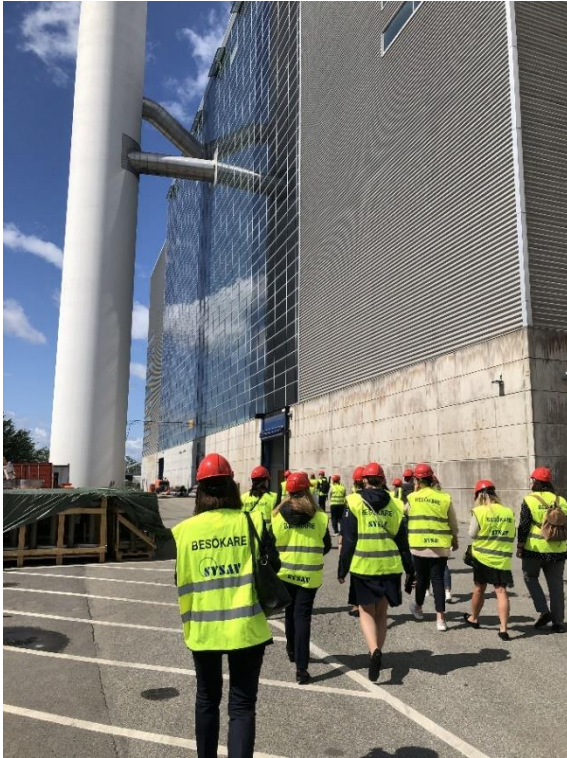
Zdjęcia 8-11. Zakład termicznego przetwarzania odpadów SYSAV [2023 r.]
