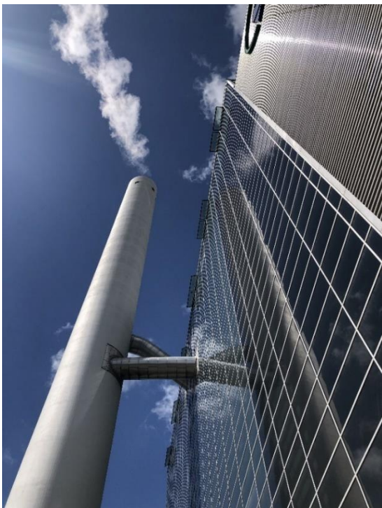
Zdjęcia 3-4. Zakład termicznego przetwarzania odpadów SYSAV [2023 r.]
