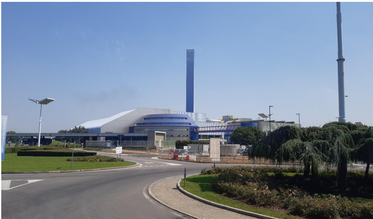
Zdjęcie 28. Zakład termicznego przetwarzania odpadów A2A [2023 r.]
