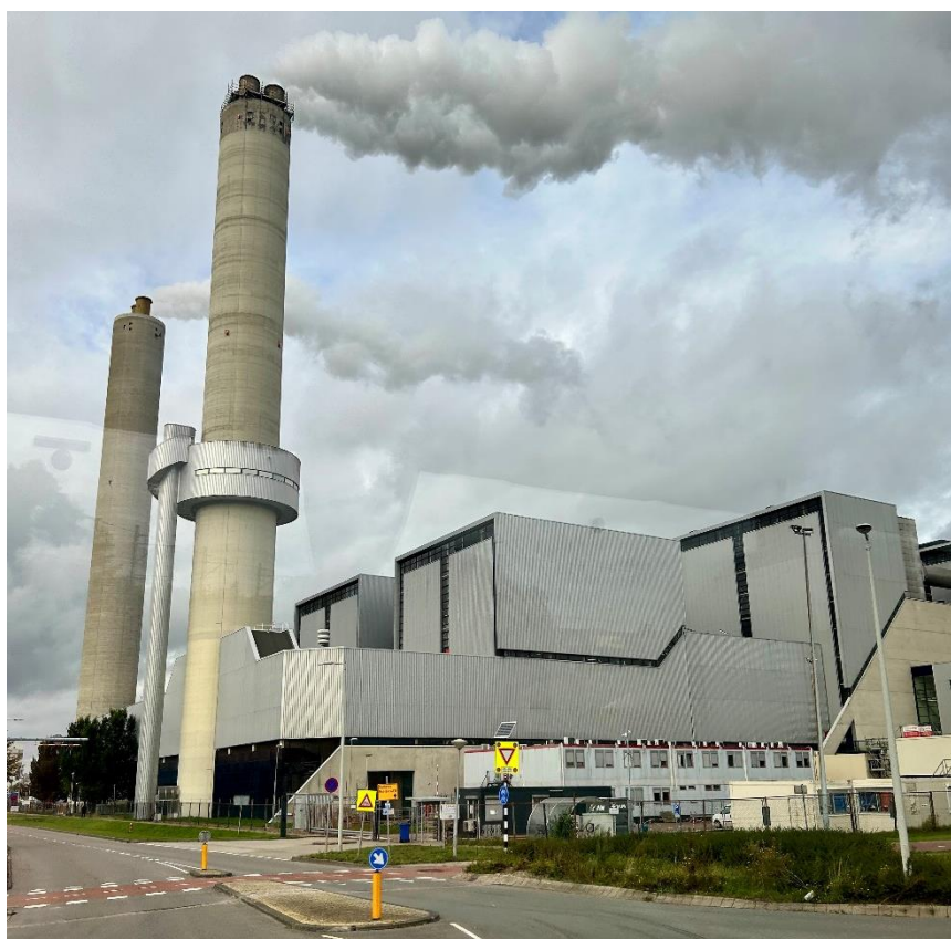
Zdjęcie 40. Zakład termicznego przetwarzania odpadów AEB Amsterdam [2024 r.]
